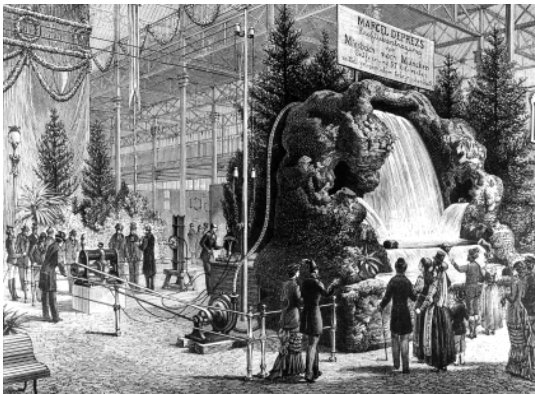
Fig. 1: Instalación de M. Desprez en el palacio de la Exposición de Munich.
